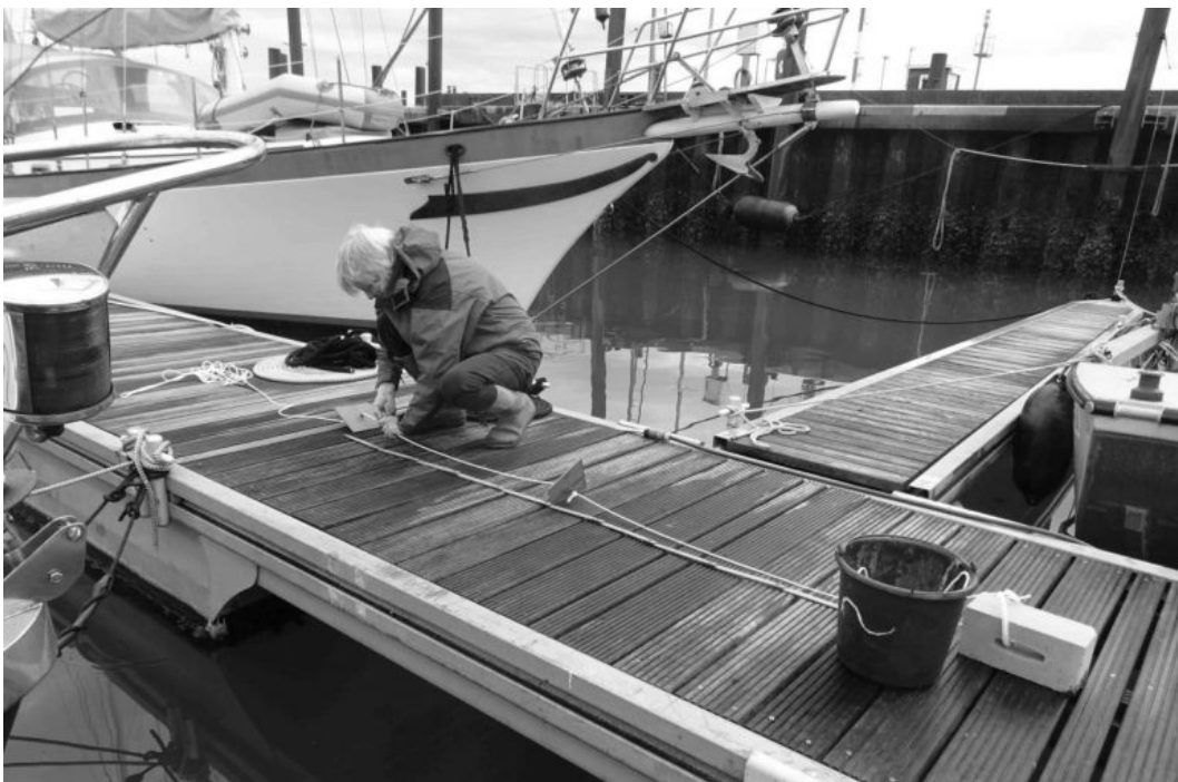
Abb. 3: Anpassen der Plattenabstände an die Wassertiefe
