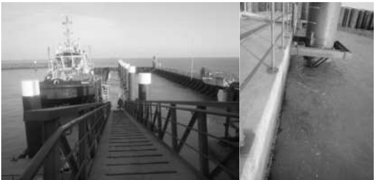
Abbildung 4: Untersuchter Schwimmponton im JadeWeserPort.
